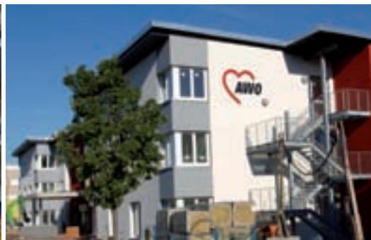
Das Berthold-Kiefer-Haus in Freiburg-Rieselfeld, kurz vor der Fertigstellung 2012.
