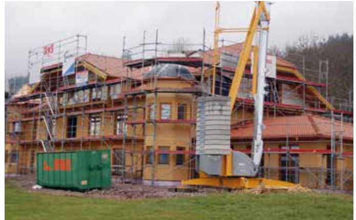
Wer will fleißige Handwerker seh'n? Der muss nach Bad Säckingen geh'n: Der Rohbau des Hotels Am Rheinsberg... Foto BZ, Siebold
